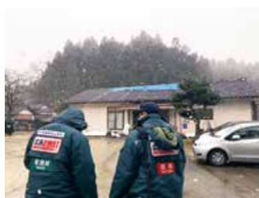
穴水町内の避難所訪問調査の様子 避難所（前方の建物）の一部は破損
